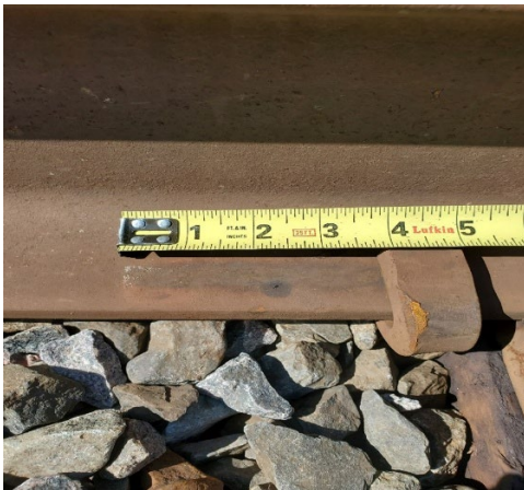
Figure 3. Anticheminant repositionné de 4 pouces au point milliaire 101,8 sur la voie principale de la subdivision de Fort Frances (Source : BST)
