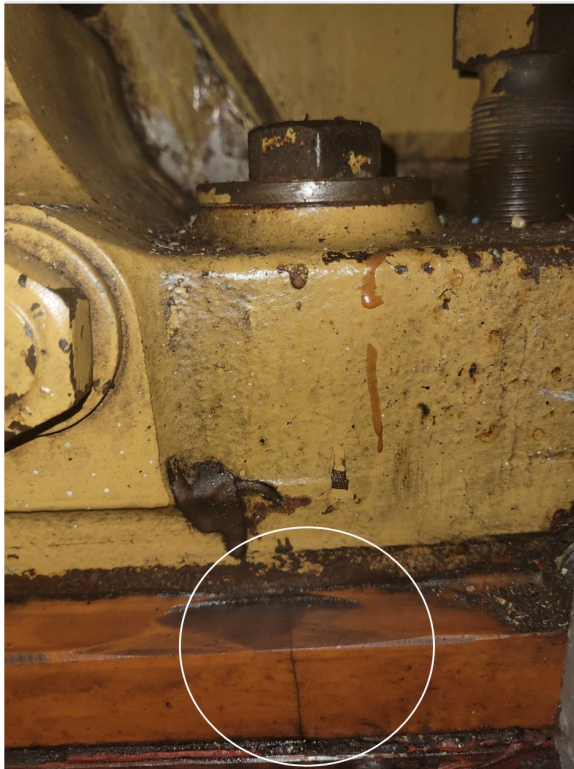
Figure 9. Photo en gros plan du support du moteur, montrant une fissure sur le support du moteur avant bâbord près des écrous (Source : BST)
